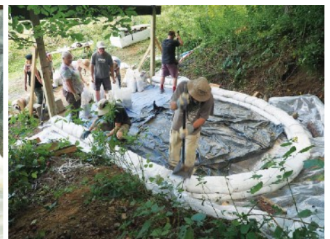
土のうを 1 段ずつ敷き詰めた後、タンピング (叩き固め) を行い、水平・鉛直を確認し、必要に応じて調整する。
