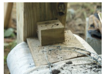
壁の 30cm ごとにストリップアンカー [板状の埋め込み固定具] を敷設する。
