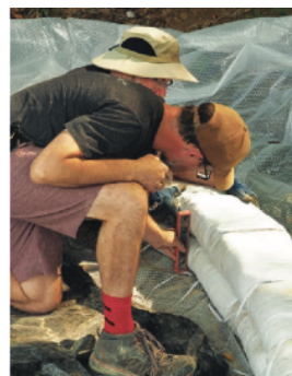
土のうを 1 段ずつ敷き詰めた後、タンピング (叩き固め) を行い、水平・鉛直を確認し、必要に応じて調整する。
